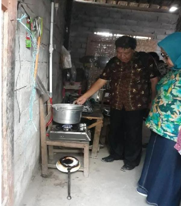
Gambar 3. Salah satu kompor dengan sumber energi terbarukan dari kotoran sapi
