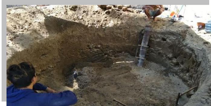
Gambar 1. Proses penggalian pembuatan digester pengolah kotoran sapi menjadi energi
