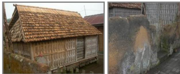
Gambar 5. Material pondasi dan dinding *Panyengker* dari tanah
